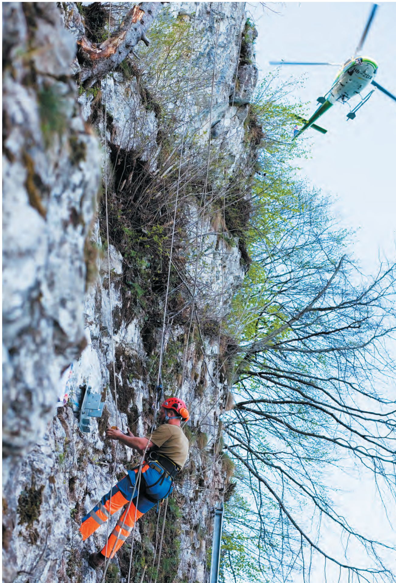
«Kamikazetypen sind hier fehl am Platz»: Arbeit in der hohen Nordflanke beim Hammetschwand-Lift.
